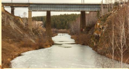
Мост через Каменку
